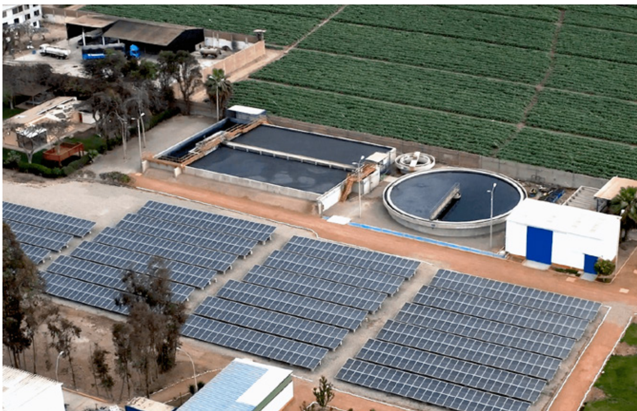
PTAR en Sede Chíncha
